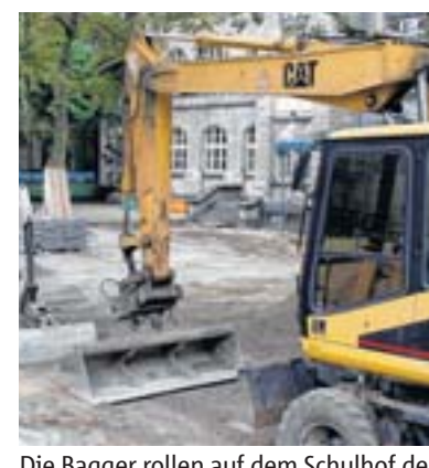
Die Bagger rollen auf dem Schulhof der Grundschule St. Josef .
